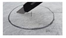
3. Die aufgeschnittene Noppenbahn an dem Rohr vorbeiführen, bis das Rohr in dem dafür vorgesehenen Kreis oder "X" Ausschnitt positioniert ist.
